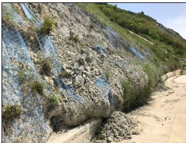
Figura 5.6: Deformimet dhe çarjet që kanë pëzuar rrjetat mbajtëse për shkak të shkrifërimit të argjilës
