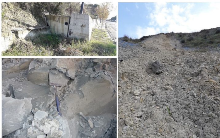
Figura 3.4: Paraqitje e argjilës në kodrën e Currilave: (sipër majtas) zhvendosje e murit mbajtës anësor si pasojë e tendencës së bymimit; (poshtë majtas) argjila rrënjësore; (djathtas) argjila e tjetërsuar që përbën trupin rrëshqitës.
