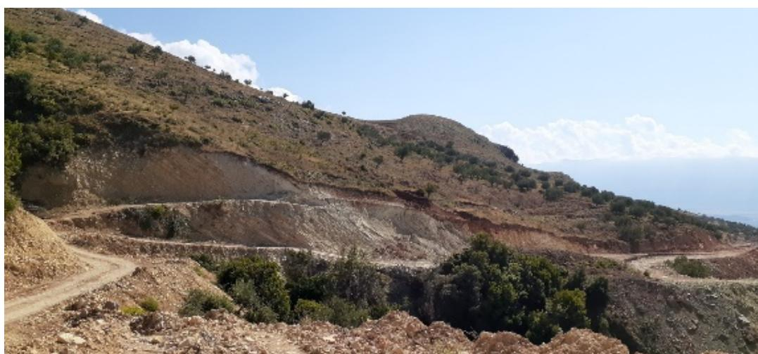
**Figura 4-7 Rrëshqitje Planare në ByPass Vlora km 17+350**
