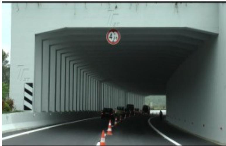
Figura 2-11 Tuneli për stabilizimin e shpatit (Monitor.al, 2019)
