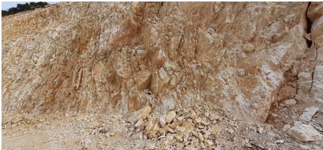
**Figura 4-11 Shëmbjet në ByPass Vlora km 14+700**
